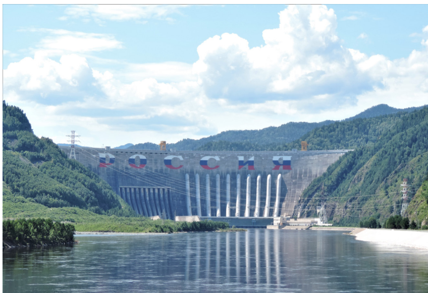
Саяно-Шушенская ГЭС. Период строительства 1961–2000 гг. Фотография Н. В. Обнорской
